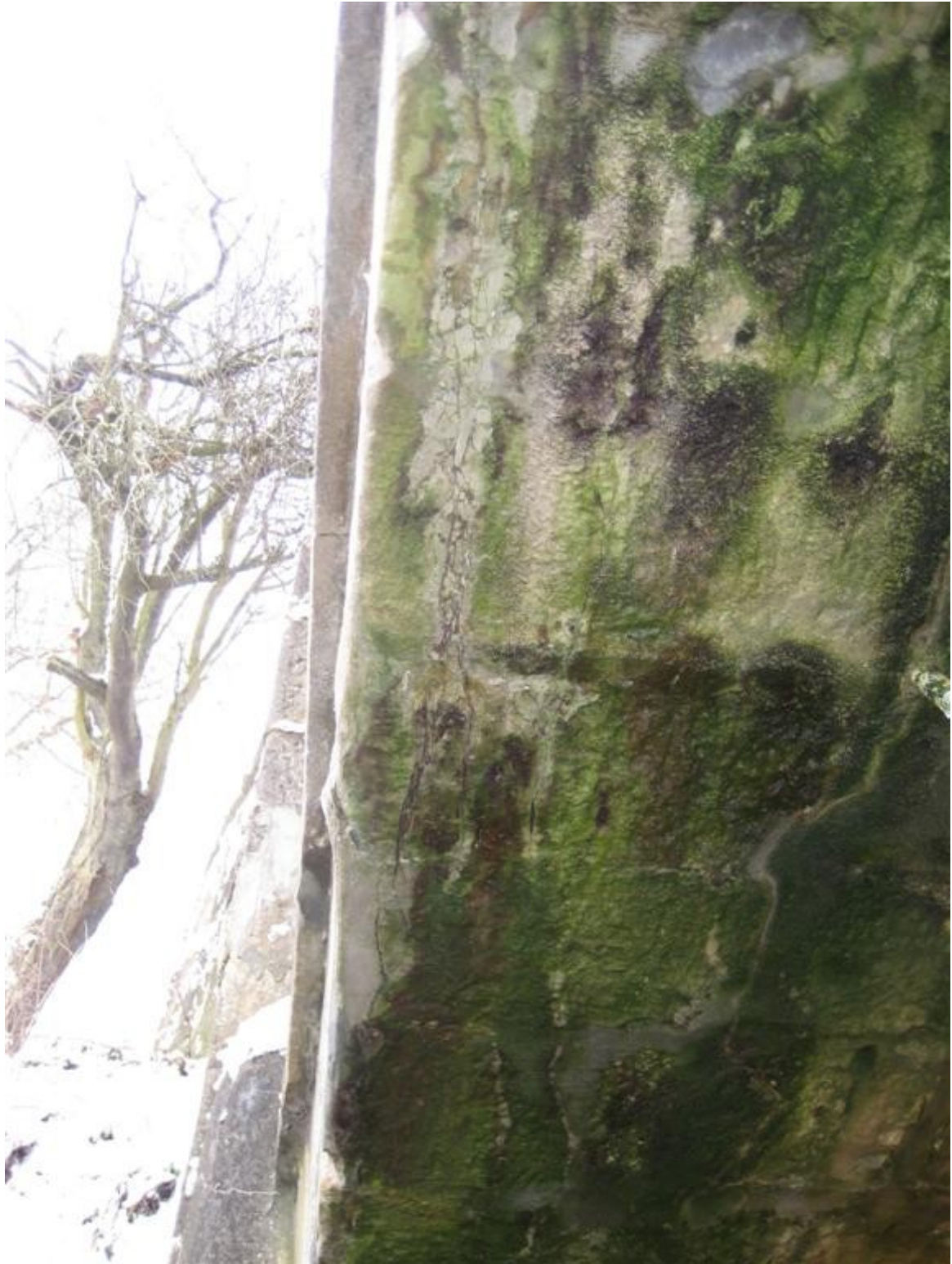
Cracking in arch voussoirs
