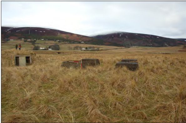
Site 298 - Mast Base & Bunker.
